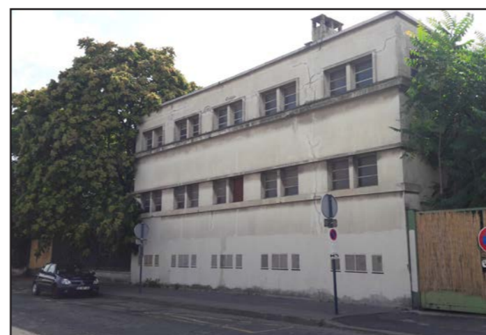
⑦ LE BÂTIMENT TECHNIQUE
